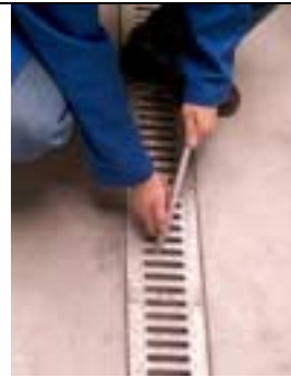
Led utloppet till en lämpad avloppspunkt i närheten av PURO GRAND
