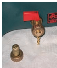
Purga de mantenimiento
